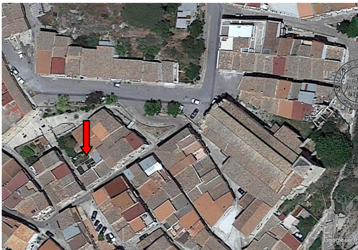
Foto n. 4 – Foto aerea dell'anno 2018 estrapolata da Google Earth. La freccia rossa indica la porzione di copertura diruta col passare degli anni. Oggi l'immobile è stato dichiarato inaccessibile e inagibile.
